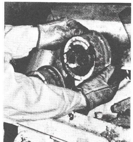
3 Si el rodillo, buje o eje está gastado, se puede reemplazar rápidamente sin necesidad de desensamblar la cadena.
